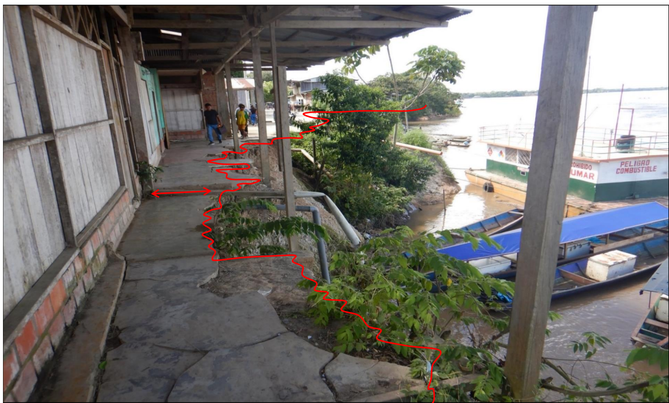
FIGURA N°01: EL JIRÓN MARAÑÓN Y LAS VEREDAS DE LAS VIVIENDAS AFECTADAS POR LA EROSIÓN DEL SUELO Y EXPUESTAS A DESBARRANCAMIENTO. LAS PERSONAS AÚN UTILIZAN ESTAS VÍAS AL NO CONTAR CON OTRA ALTERNATIVA DE ACCESO.
