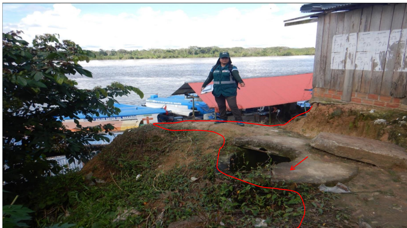
FIGURA N°03: VIVIENDAS FAMILIARES, BUZONES COLECTORES DEL SERVICIO DE SANEAMIENTO, DETERIORADOS, AFECTADOS Y EN ZONA DE RIESGO POR LA EROSIÓN DEL SUELO
