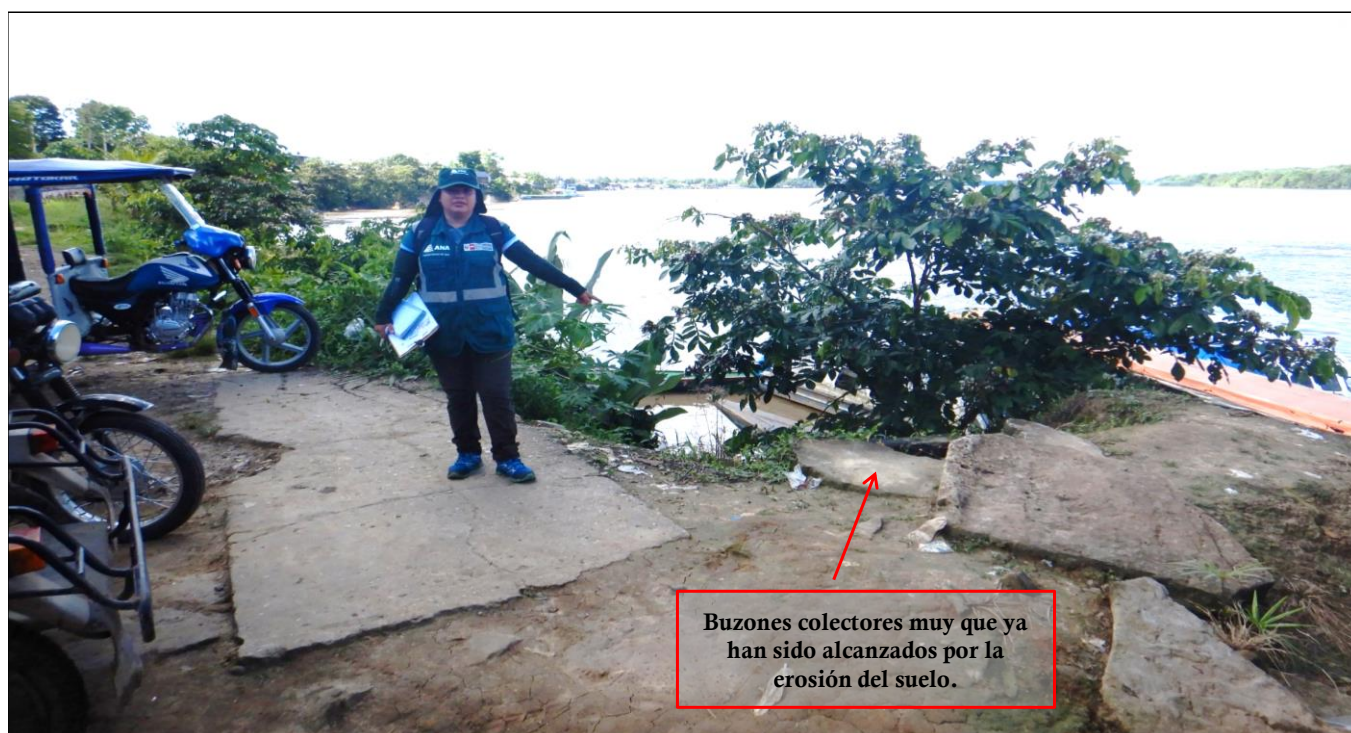
FIGURA N°05: PÉRDIDA DE ESTRUCTURAS VIALES POR EFECTOS DE LA EROSIÓN DEL SUELO.
